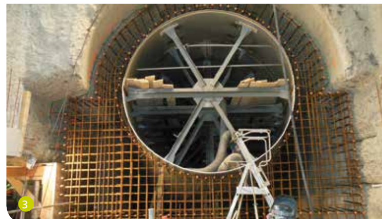
3 Le conduit de sortie de l'un des deux nouveaux groupes. Des barres métalliques sont placées à l'intérieur du conduit pour empêcher les déformations induites par le bétonnage, elles sont retirées après la prise du béton.
