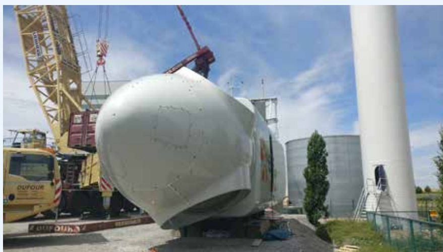
Construction de l'éolienne du site de Fri-Pharma.
