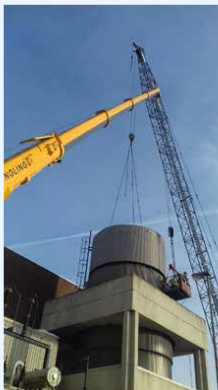
Démantèlement de la cheminée de la turbine de la centrale de Monsin, en plusieurs étapes.
