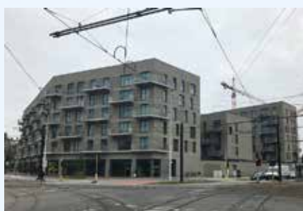
Première phase de construction du nouveau quartier Rabot terminée, avec trois bâtiments comprenant 131 appartements sociaux et trois espaces commerciaux en rez-de-chaussée.
