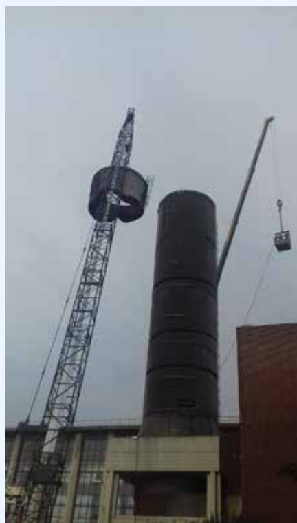
Démantèlement de la cheminée de la turbine de la centrale de Monsin, en plusieurs étapes.
