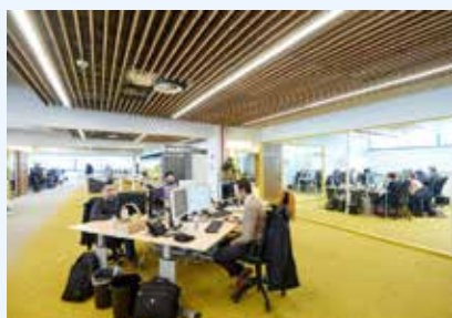
Les nouveaux locaux vus de l'intérieur. Le faux plafond en bois favorise une bonne acoustique à cet étage.
