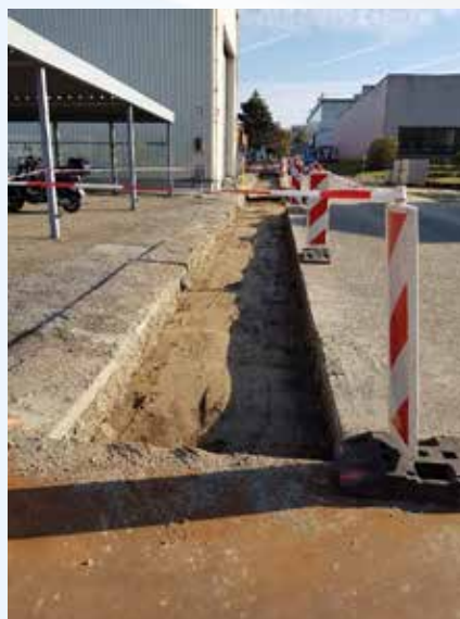
La pose des panneaux photovoltaïques a nécessité la rénovation des installations électriques sur une grande partie du site.
