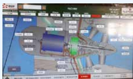
L'interface homme-machine intuitive disponible sur les nouvelles armoires électriques d'Ampsin.
