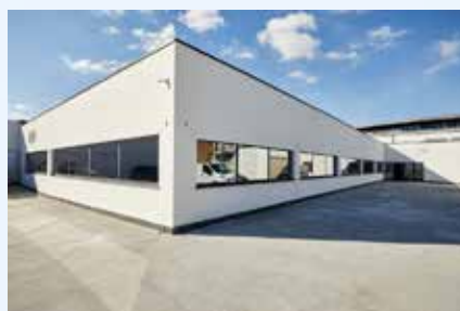
Les fenêtres du bâtiment (ici le premier étage) sont teintées à 80%, ce qui réduit les problèmes de trop forte chaleur en été.
