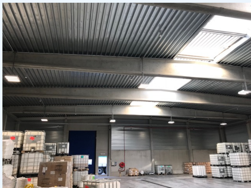
Les luminaires existants ont été remplacés par des luminaires de type LED.
