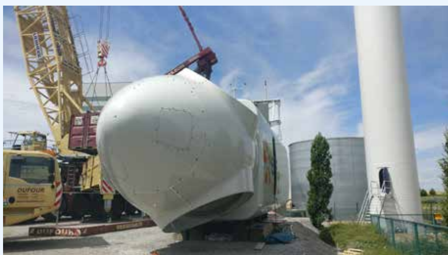
Construction de la tour de l'éolienne sur le site de Fri-Pharma.
