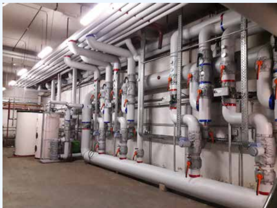
Isolation de la distribution d'eau chaude de l'un des sites du Foyer Anderlechtois.
