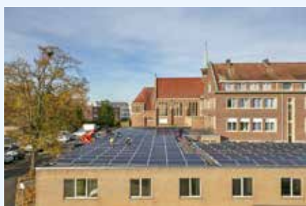
Installation des 815 panneaux solaires sur le toit de la maison de repos et de soin Damiaan.
