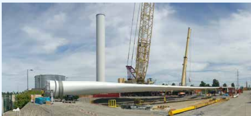
Construction d'une éolienne sur un site industriel.
