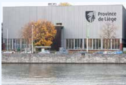
Façade rénovée en zinc à l'école polytechnique de la Province de Liège, à Huy.
