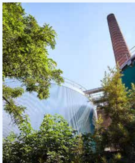
L'ancienne cuve de stockage de fuel du site de Gand-Ham transformée en réservoir d'eau chaude.
