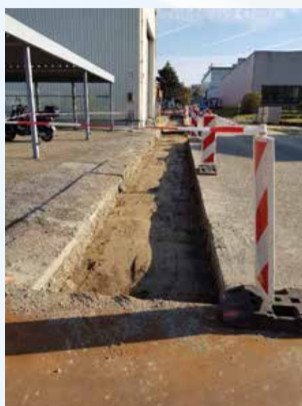
Voor de plaatsing van de fotovoltaïsche panelen moesten de elektrische installaties op een groot deel van de site worden gerenoveerd.
