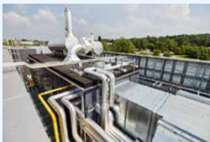
Vanparijs Engineers plaatste de warmtekrachtkoppeling gebruiksklaar op het dak van het gebouw, een technisch huzarenstukje.
