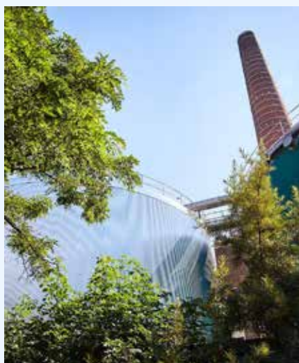
De oude brandstofopslagtank van de site van Gent-Ham werd omgevormd tot een warmwateropslagtank.
