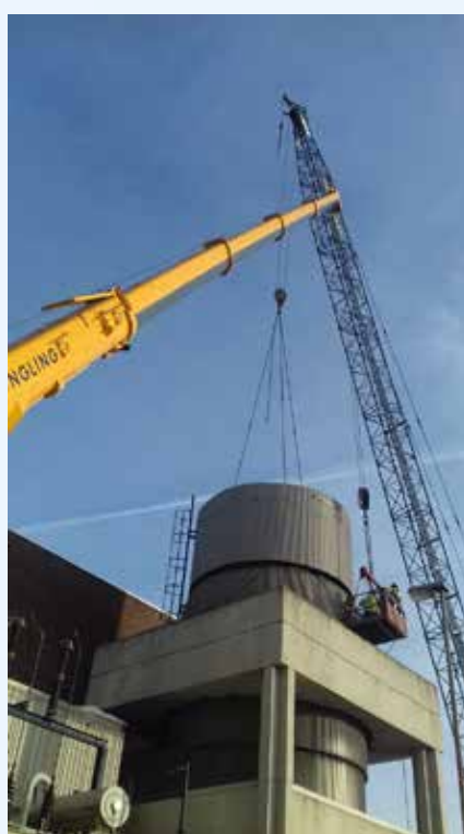
Ontmanteling van de schoorsteen van de turbine van de centrale van Monsin, in verschillende stappen.
