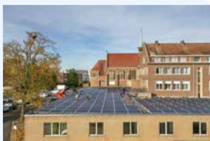
Installatie van 815 zonnepanelen op het dak van woonzorgcentrum Damiaan.
