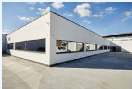
De ruiten van het gebouw (hier op de eerste verdieping) zijn voor 80% getint, wat problemen in verband met overmatige hitte in de zomer vermindert en de leesbaarheid van de schermen bevordert.
