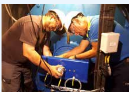
Plaatsing van de toerentalsensor van de turbine.
