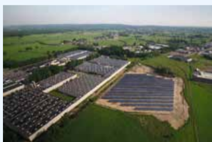
In totaal is de NMC-vestiging in Raeren uitgerust met bijna 9 000 panelen met een totaal vermogen van 2,2 MW.
