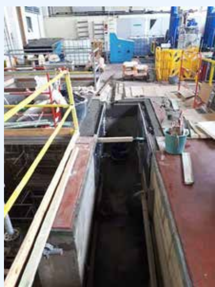
Civiltechnische voorbereiding voor de installatie van de retentietank op het hoogste niveau van de centrale.
