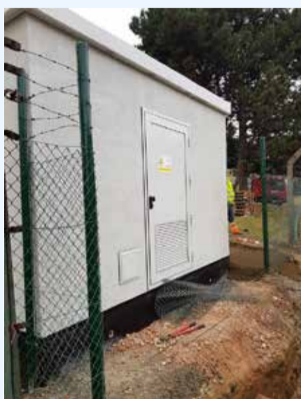
Installatie van de hoogspanningscabine.
