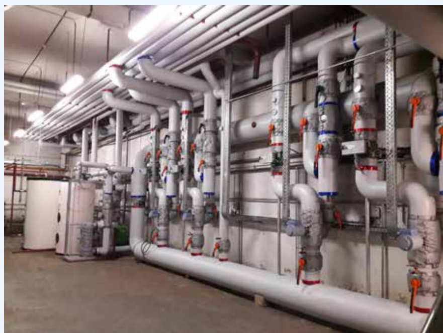
Isolatie van de warmwaterdistributie van een van de sites van de Anderlechtse Haard.
