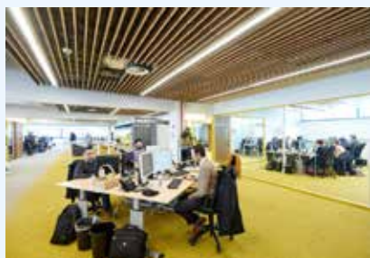
De nieuwe lokalen gezien van binnenuit. Het valse plafond in hout bevordert een goede akoestiek op deze verdieping.
