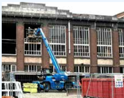
Vervanging van het raamwerk als onderdeel van het energieprestatiecontract ondertekend met Renowatt in 2016.
