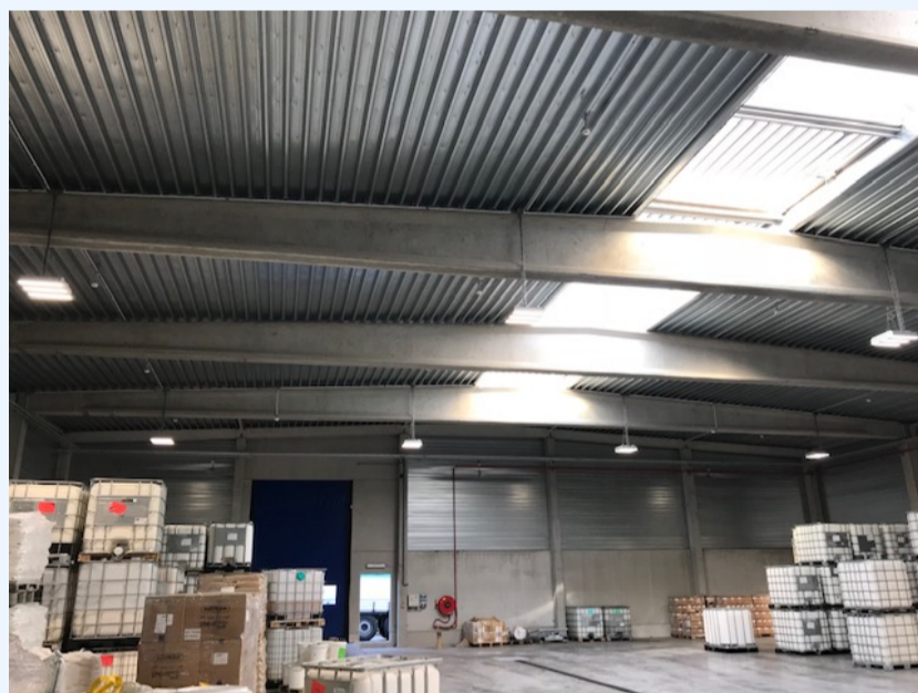
De bestaande armaturen werden vervangen door LED-armaturen.
