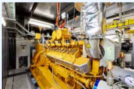
De motor van de warmtekrachtkoppelingseenheid in zijn akoestische behuizing.
