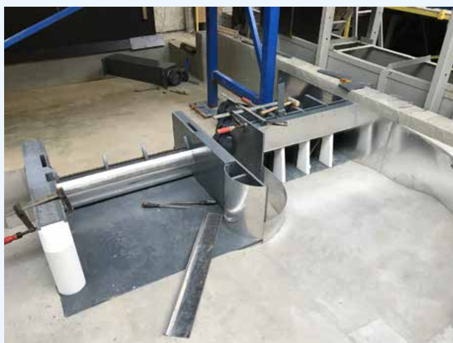
Bouw schaalmodel door de universiteit van Luik voor de stroomafwaartse uitlaten van de site van Grands-Malades.
