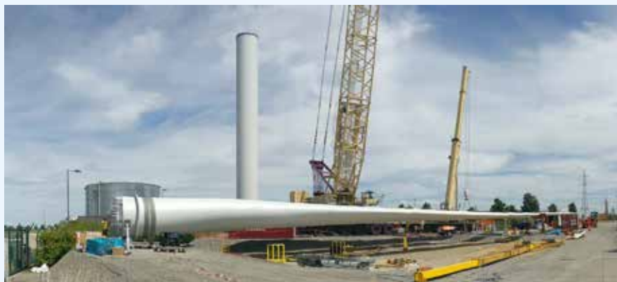
Bouw van een windturbine op een industriële site.
