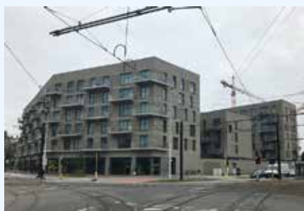
Eerste bouwfase van de nieuwe Rabotwijk afgerond, met drie gebouwen met 131 sociale appartementen en drie handelsruimten op het gelijkvloers.
