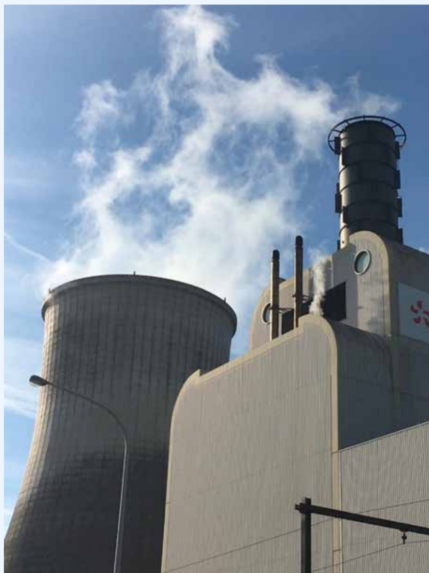
Heropstart van de centrale met gecombineerde cyclus van Seraing, in oktober 2018.
