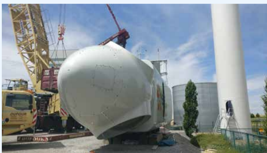
Bouw van de windmolentoren op de site van Fri-Pharma.
