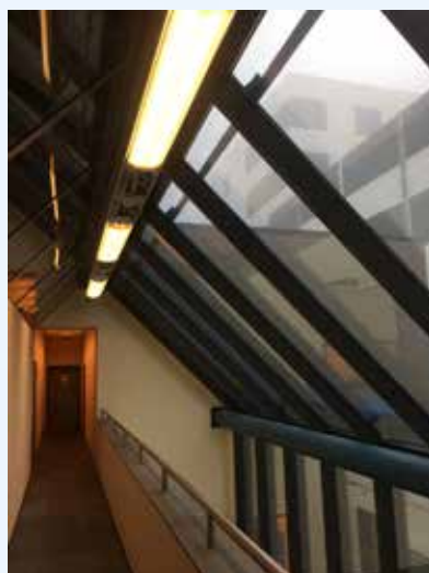
De verlichting van de Ringvaart-site werd vervangen door LED-verlichting.
