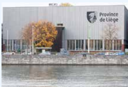
Gerenoveerde zinken gevel aan de polytechnische school van de provincie Luik, in Hoei.
